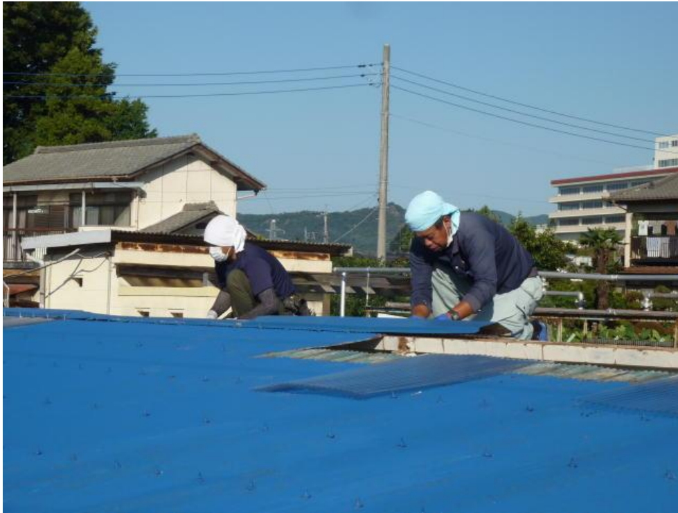
屋根の張替え（吹上中）
